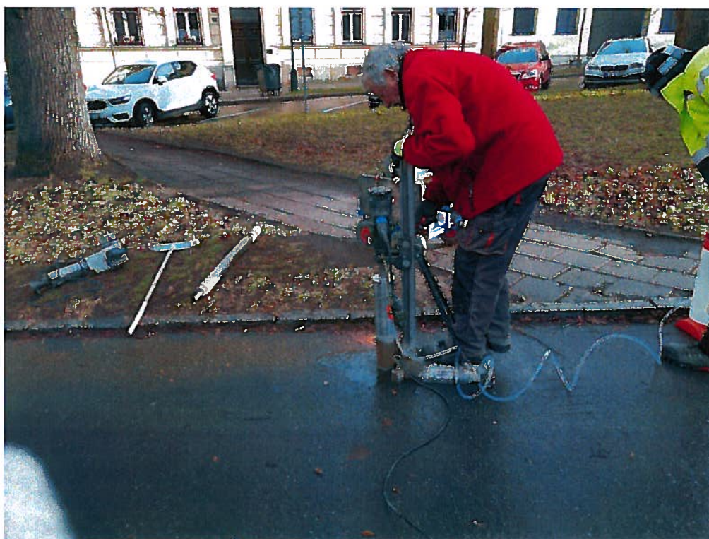
Foto č. 04: Vrtaná sonda VS-2
