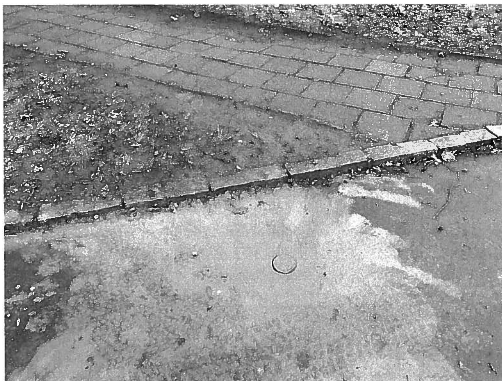
Foto č. 06: Finální zapravení jádra sondy VS-2
